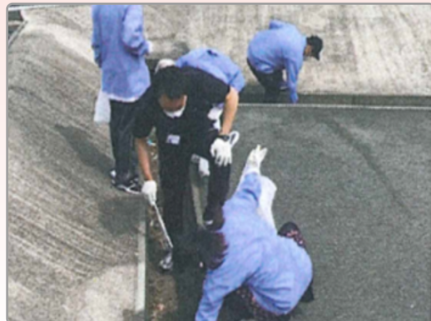
《水路内の清掃!!》
